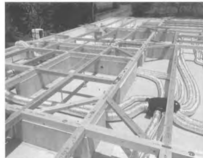
③施工の様子
